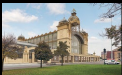
Průmyslový palác Kompletní rekonstrukce Průmyslového paláce včetně dostavby levého křídla. → zahájení 2021
